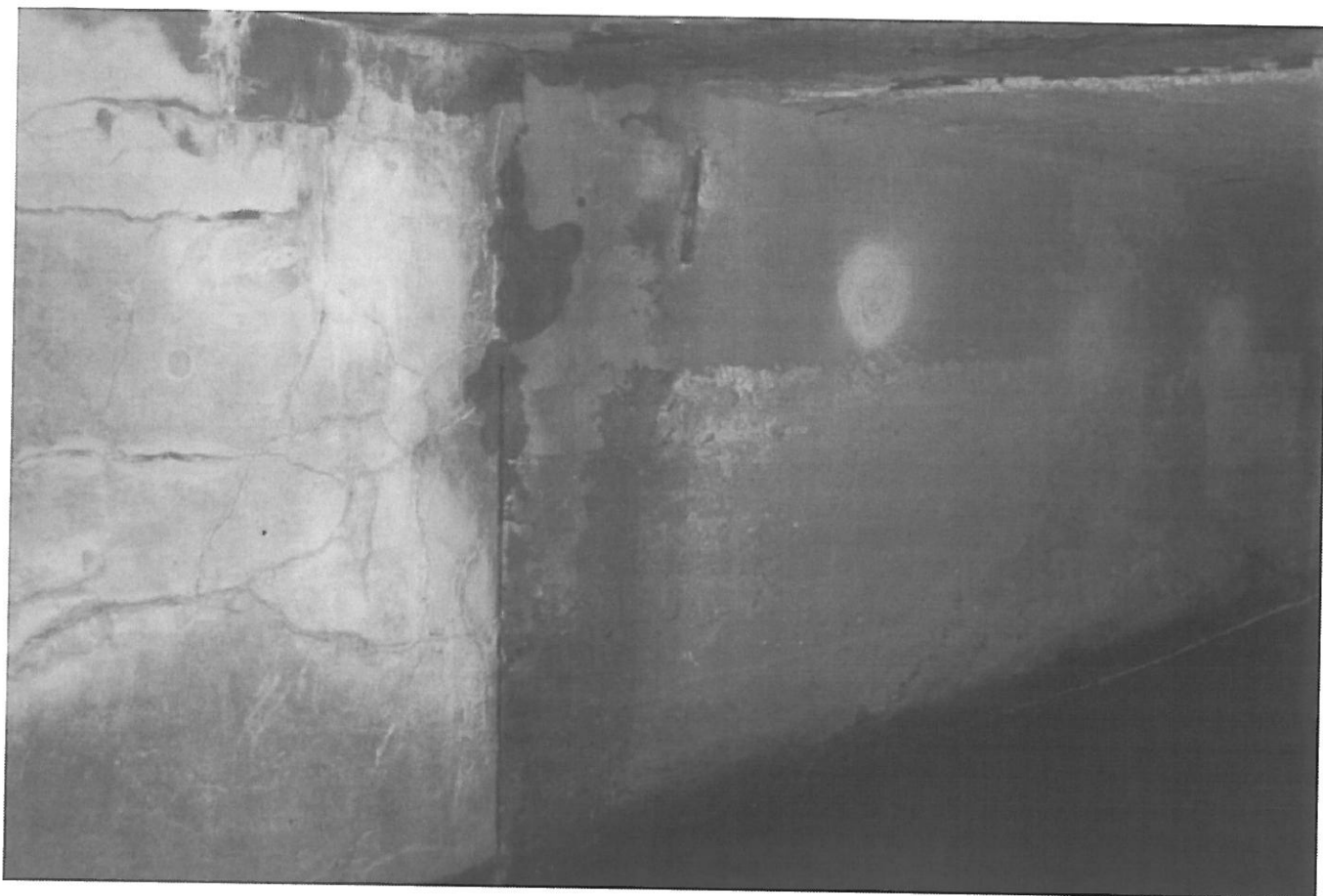
dilatační napojení staré a nové (pravé) části mostu
