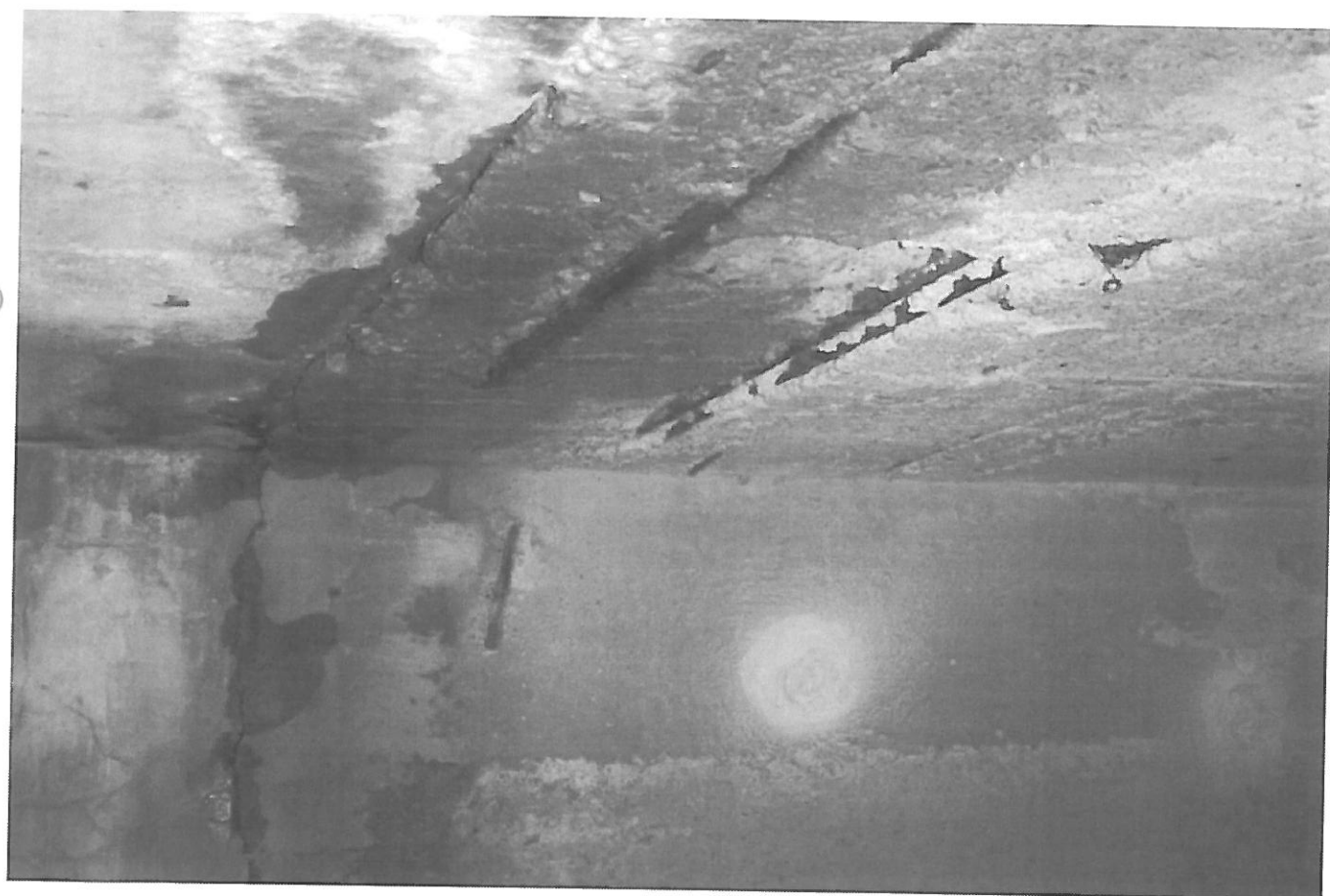
protékající spojení rozdílných částí mostu a hloubkově narušená (zkorodovaná) výztuž pravé části mostu
