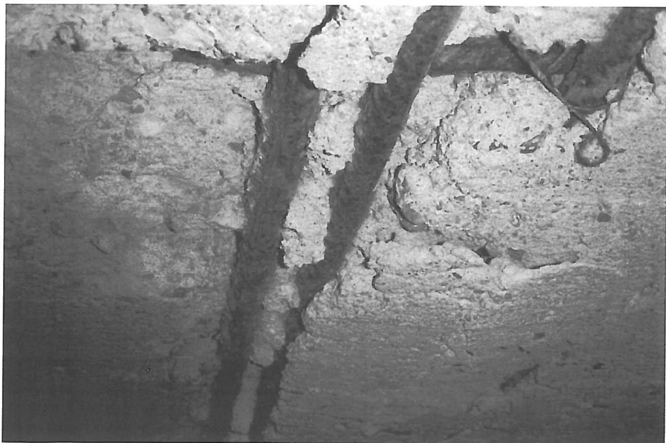
detail zkorodované výztuže v nové (pravé) části mostu
