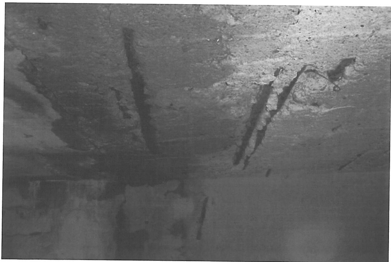
zkorodovaná výztuž v oblasti spojení mostu
