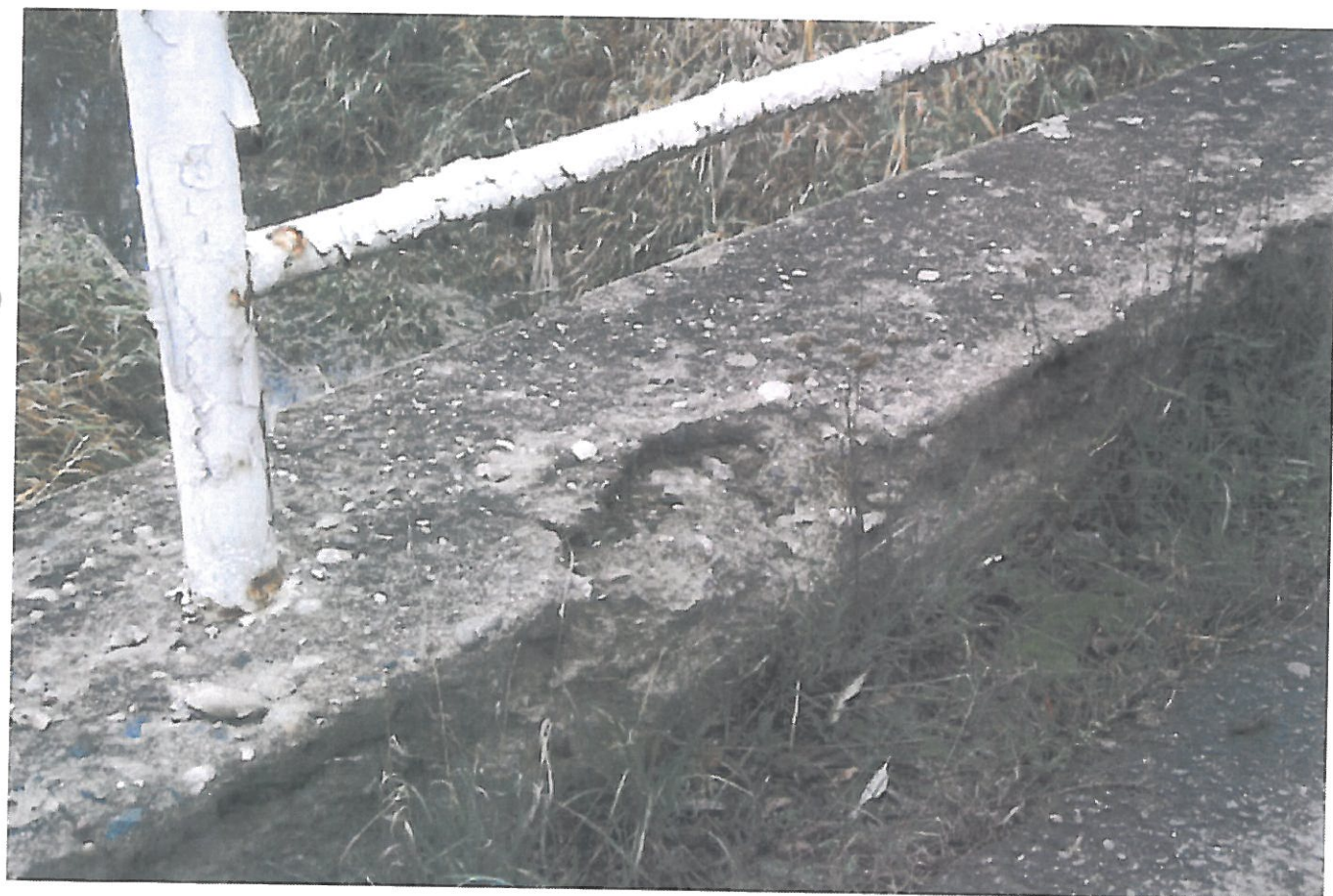
hloubkově poškozený beton římsy po pravé straně mostu (pohled proti směru staničení)
