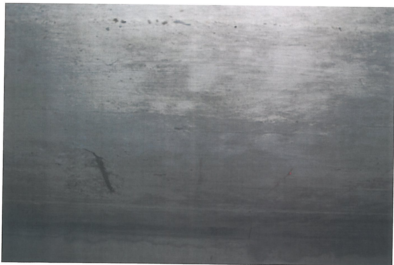
částečně obnažená výztuž a elektromagnetickou sondou zjištěná v podhledu desky ve staré části mostu
