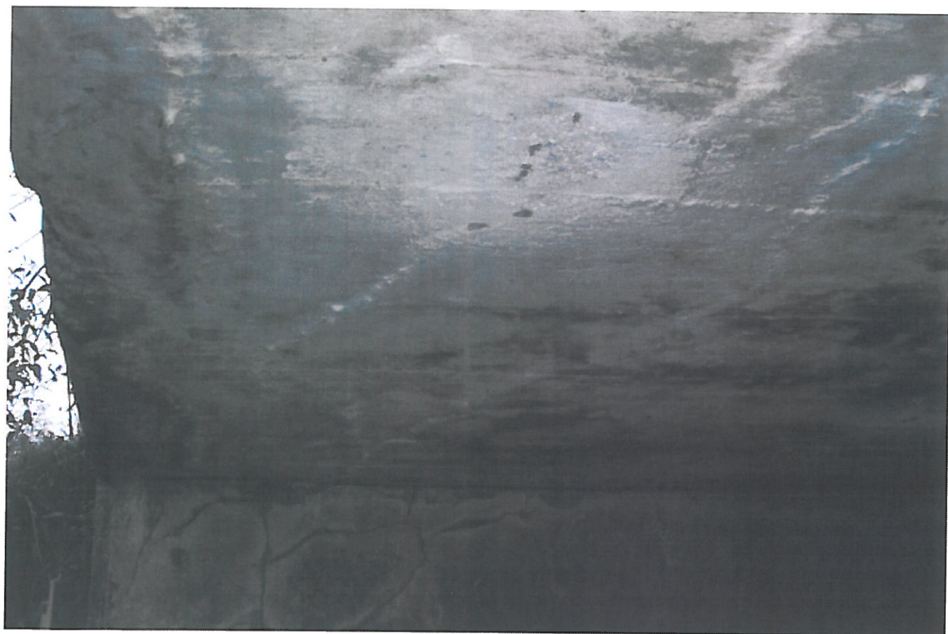
protékající hydroizolace v podhledu mostu po levé straně
