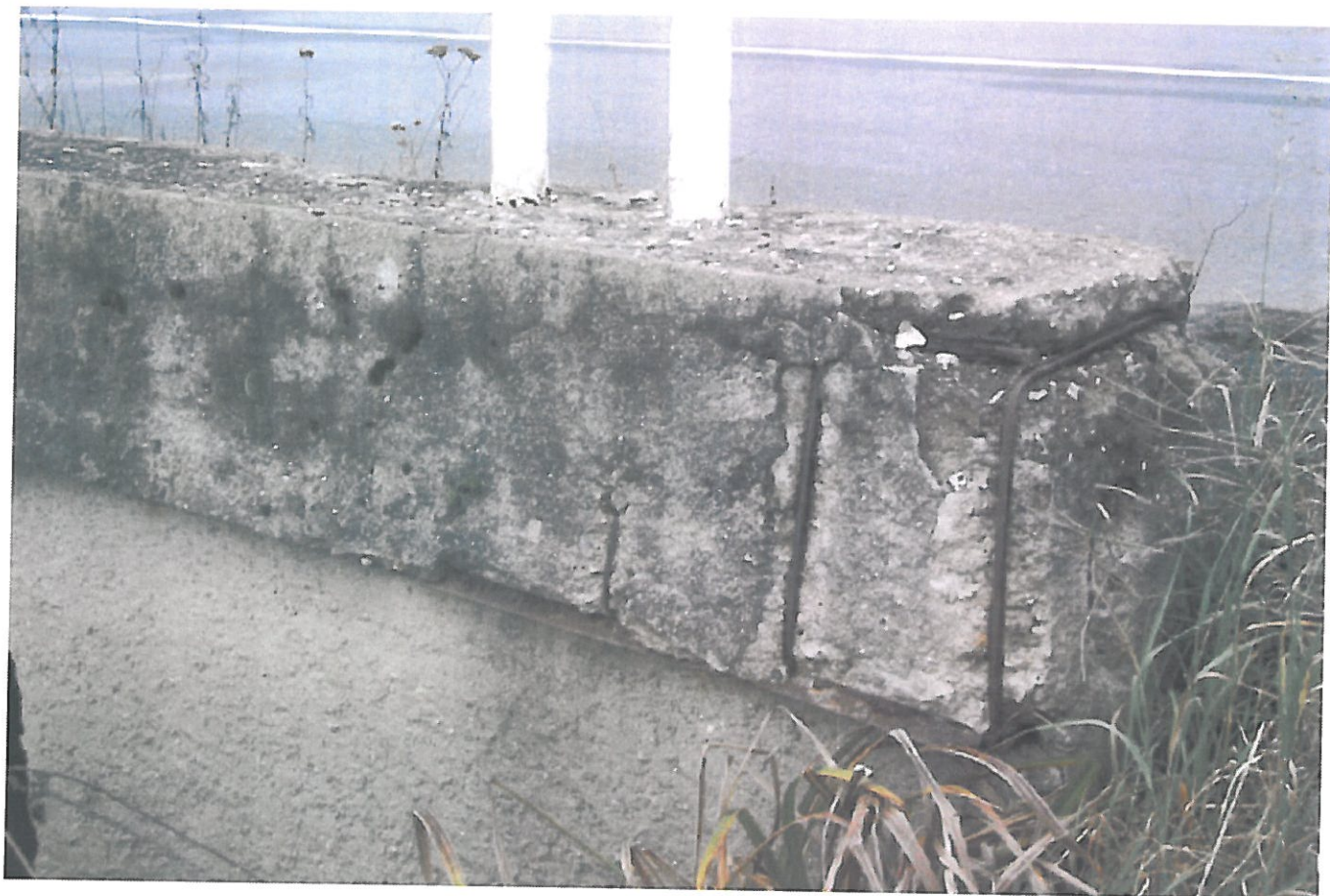
obnažená výztuž a degradovaný beton římsy na konci mostu vpravo
